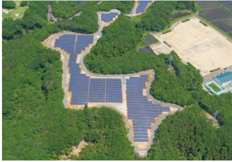
リゾートトラスト メガソーラー那須白河
