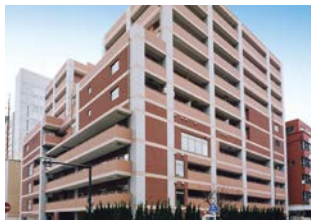
トラストガーデン横浜ベイ馬車道 ●横浜市中区元浜町2-13-1 ※本施設は1～4階部分
